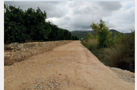
Reparació camí llavador
