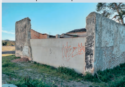
Reparacions a la Servana
