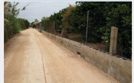
Reparació camí de la marjal
