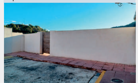
Cobriments de l'aigüera del C/Colón i reparació del mur de tancament
